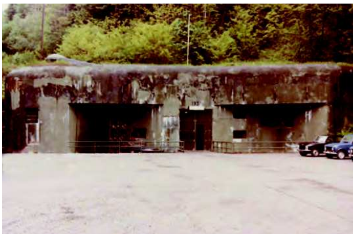
Entrée de l'ouvrage du CDC.
