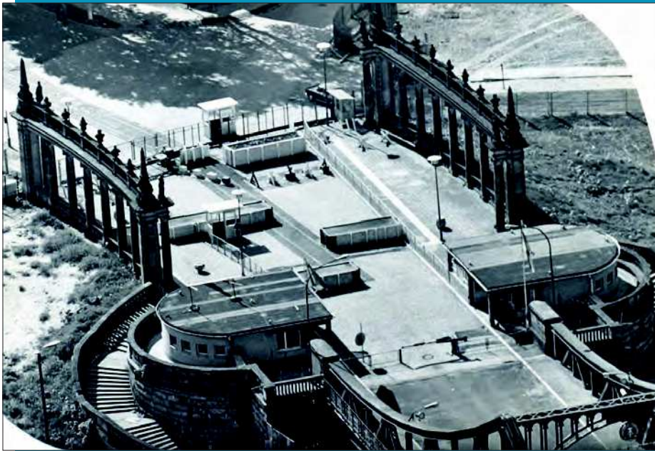
Entrée du pont de Glienicke du côté soviétique.
