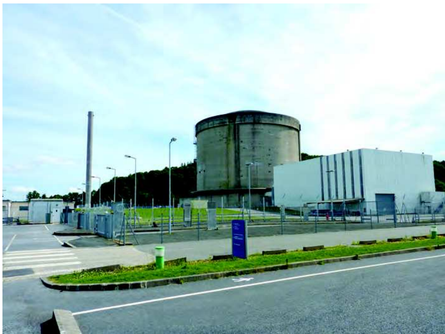
La centrale nucléaire de Brennilis.
