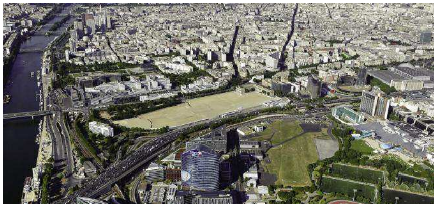
Chantier de Balard.
