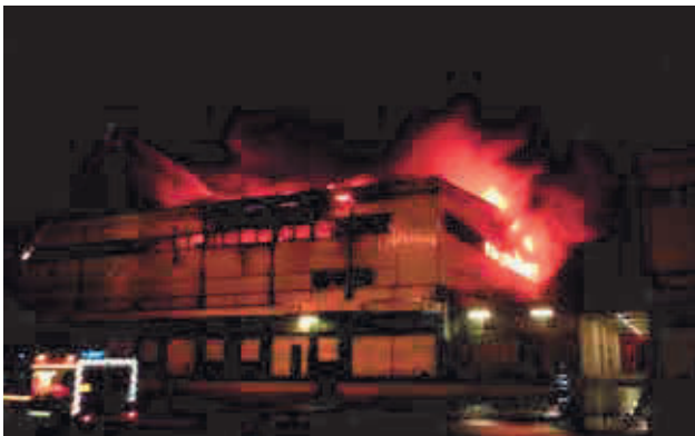
Feu entrepôt - photo auteur.
