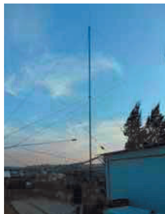
Une antenne au haubanage compliqué
