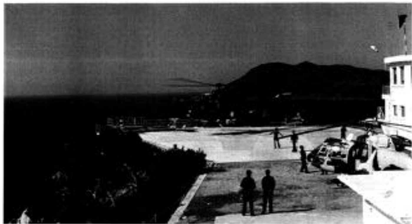
LA RENARDIERE ET LE CAP CEPET (1975) LA PLATE-FORME SUPERIEURE AMENAGEE POUR L'ATTERRISSAGE DES HELICOPTERES
