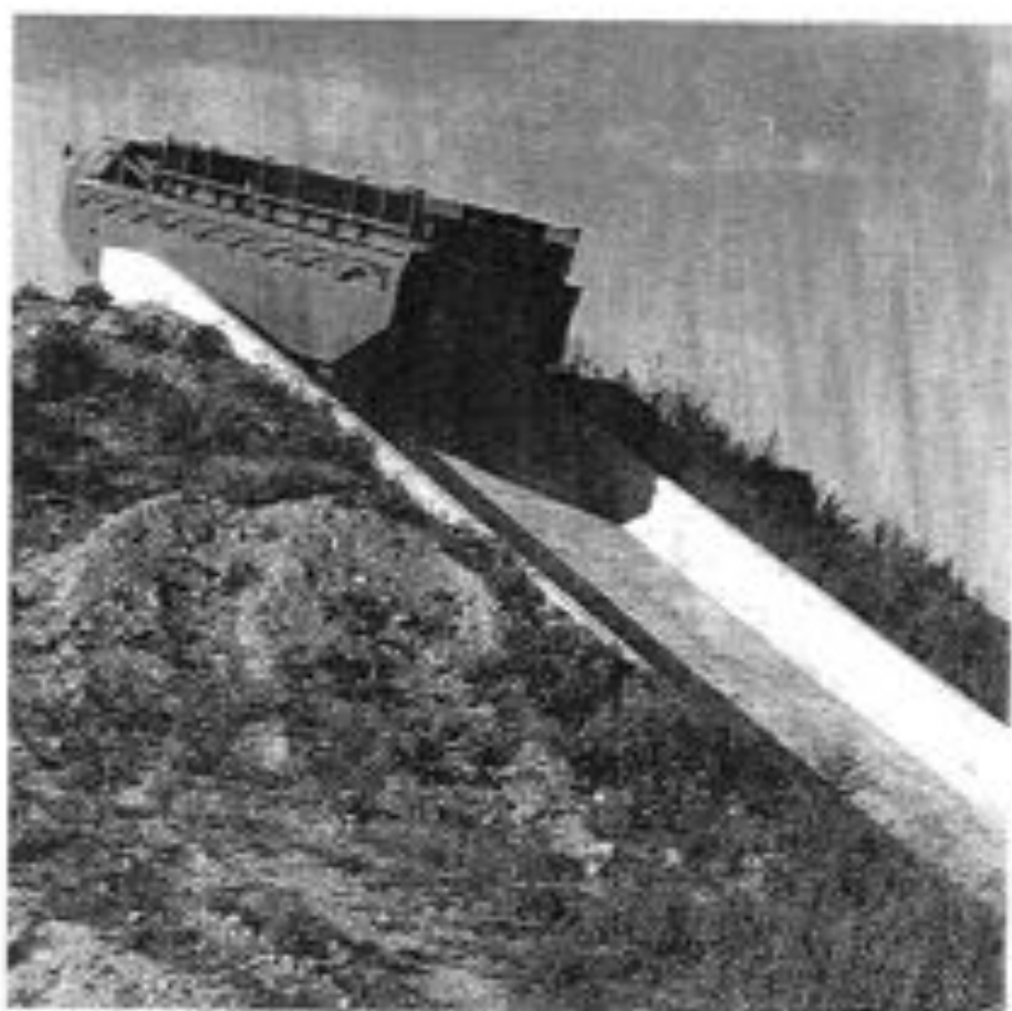
ENGIN GILLOIS SUR RAMPE 40%
