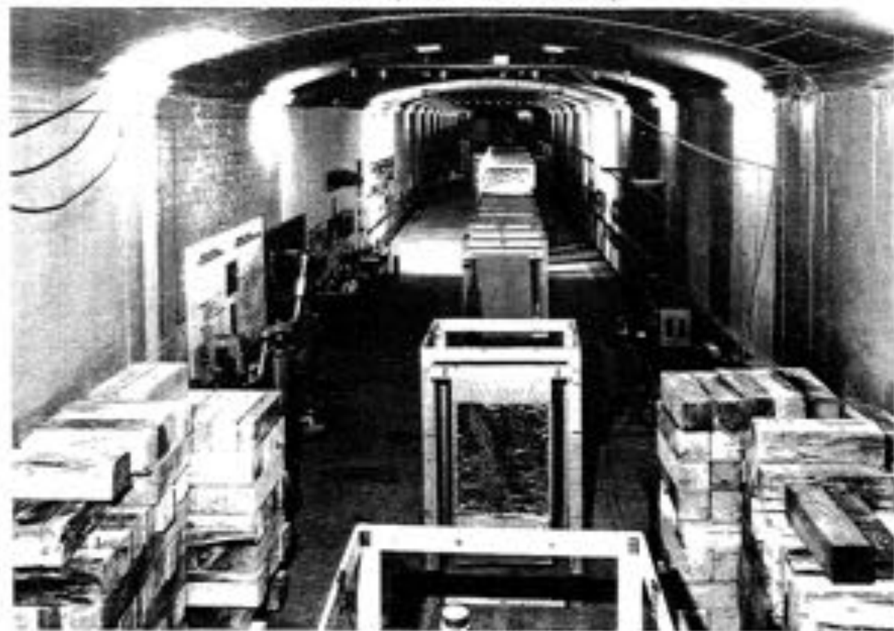
TUNNEL DE TIR DE L'ISL (VERS 1968).
