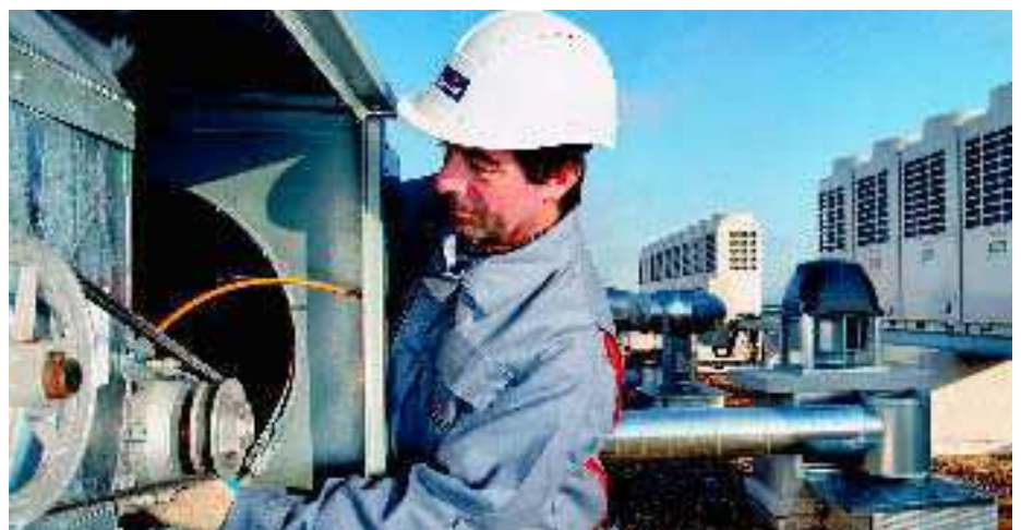
Conception, installation, maintenance d'équipements de génie climatique
