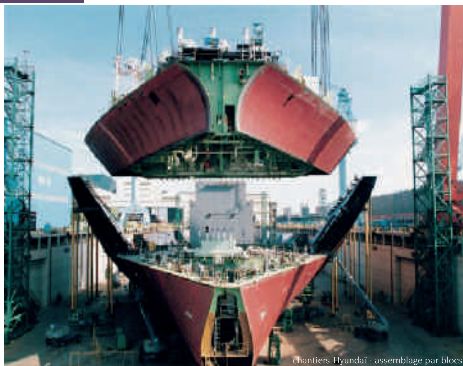
chantiers Hyundai : assemblage par blocs
