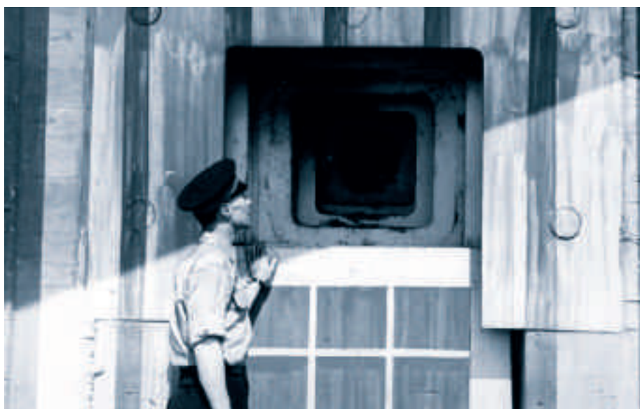
Recensement des ouvrages de côte: inspection d'une casemate antichar ex-allemande en Normandie. (SHD/M - tous droits réservés)
