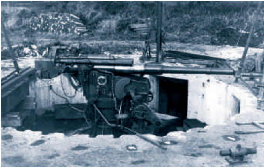
Réarmement de la batterie antiaérienne ex-allemande de Kerdelais, dominant le goulet de Brest, en 1946. (SHD/M - tous droits réservés)
