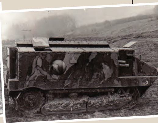
Char Schneider, équipé d'un canon de 75mm S court et de 2 mitrailleuses de 8mm sous casemate
