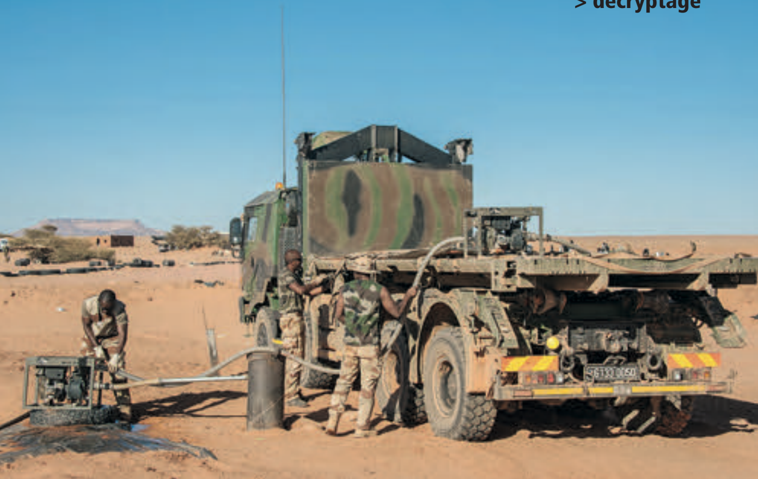
Des soldats du 6 e régiment du génie pompent l'eau du puits situé au poste-frontière entre la Libye et le Niger afin d'alimenter les réservoirs de la base.
