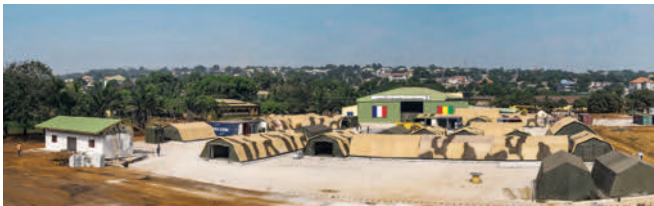
Vue générale du Centre de traitement des soignants inauguré le 19 janvier et implanté sur la base aérienne d'Alpha Yaya, à Conakry.
