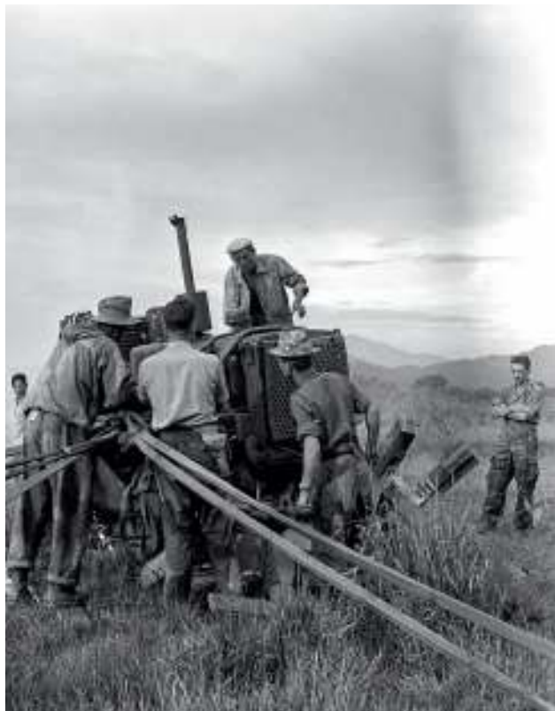
Des soldats libèrent un bulldozer Bouter R4 de ses suspentes après son parachutage sur Diên Biên Phu le 23 novembre 1953.
