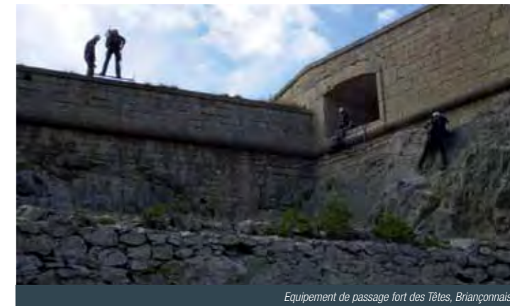
Équipement de passage fort des Têtes, Briançonnais
