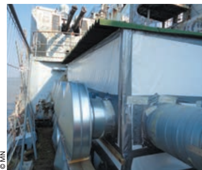
Installation d'extracteurs d'air sur l'ex-Colbert pour l'opération de désamiantage.
