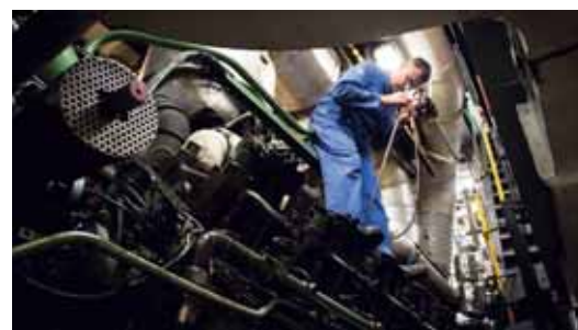
Lors d'une visite préventive, l'atelier contrôle-expertise effectue un contrôle endoscopique d'un moteur de propulsion de la FASM Latouche-Tréville .
