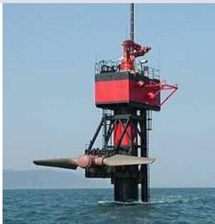
Hydrolienne sur pilier au large de l'Irlande.
